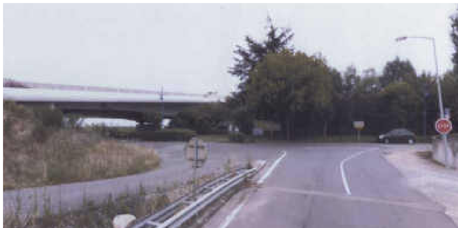
Vues paysagères du franchissement de Loire depuis les berges au nord-ouest de l'ouvrage
